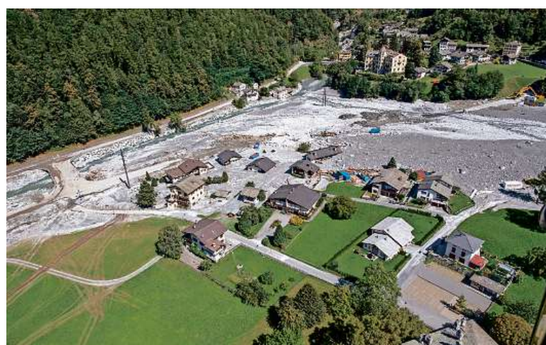
Das Gebiet in und um Bondo ist akut gefährdet. (FOTO KEYSTONE)
