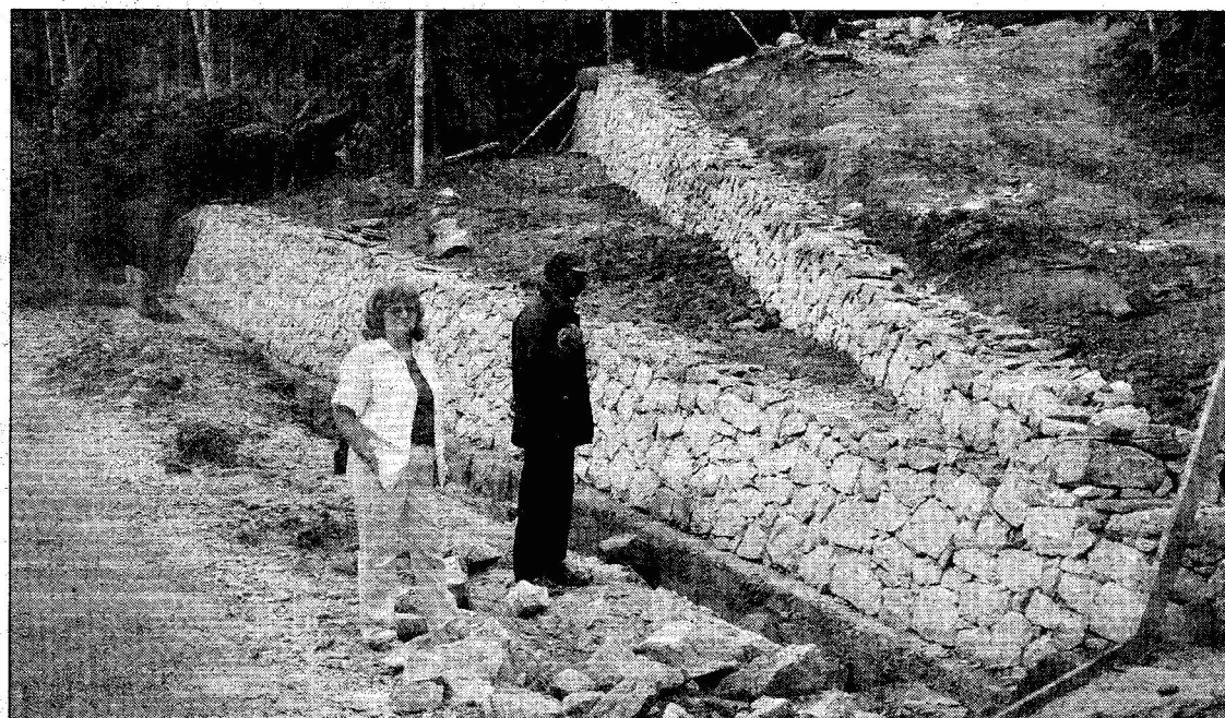
Stein auf Stein: Stützmauern verhindern, dass der Monsunregen die Zufahrtsstrasse wieder wegpült.
